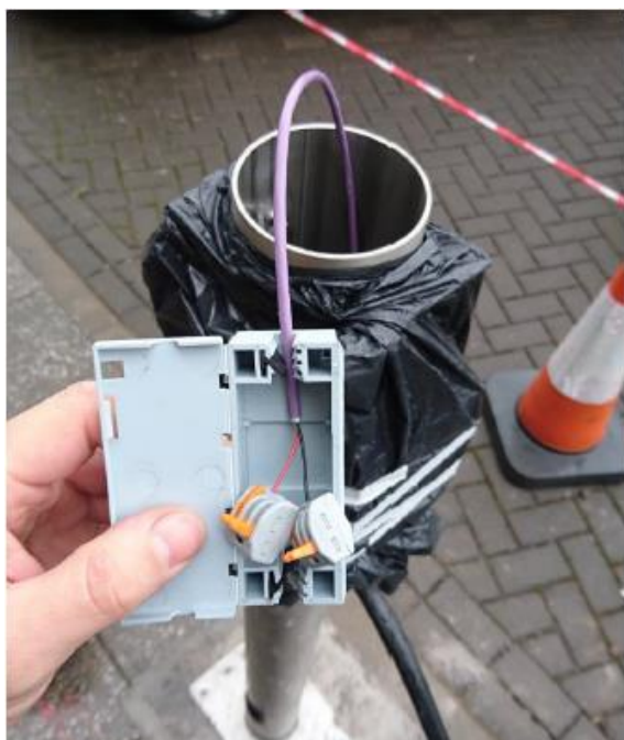
Figur 3 – Eks.på tilkobling med Wago
